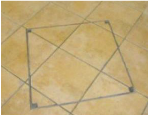
NUTNÉ NAVÁZÁNÍ SPAR DLAŽBY
